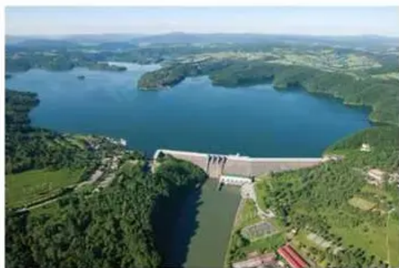
Jeziro Solińskie to największy sztuczny zbiornik wodny w Polsce (ma pojemność 472 mln m 3 wody). Jego powstanie było możliwe dzięki budowie najwyższej zapory w Polsce (82 m).
