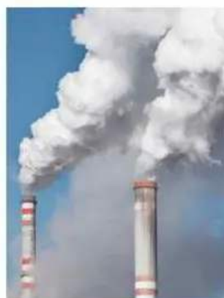
▲ Kominy elektrowni węglowej
